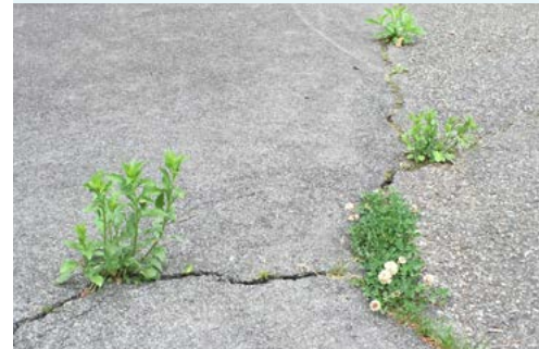
Réfection de revêtement.
